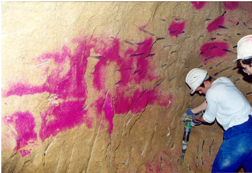
Excavación de arena de miga una vez tratada con gel de sílice.
