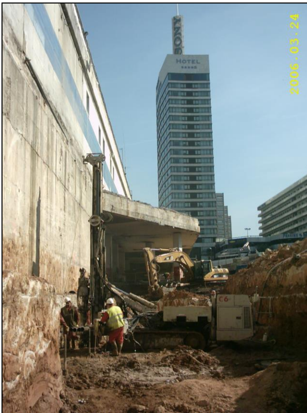
Equipo de perforación Casagrande C6 perforando
