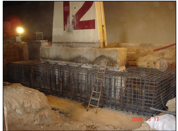
Zapata con el recalce ejecutado
